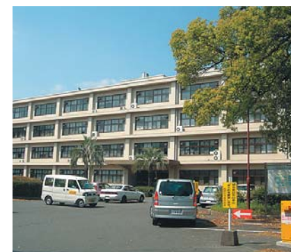
⑤薬学部本館(昭和40年~45年完成) 建築面積 2,022㎡ 延床面積 6,510㎡ 階数 地上4階 構造 鉄筋コンクリート造
