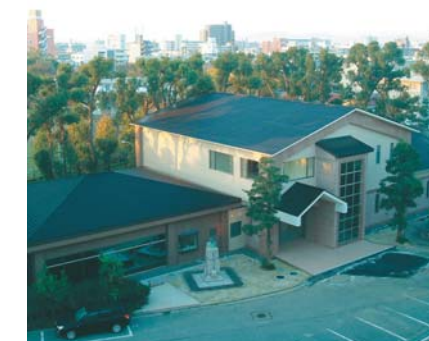
⑩宮本記念館(平成16年完成) 建築面積 774㎡ 延床面積 1,030㎡ 階数 地上2階 構造 鉄筋コンクリート造
