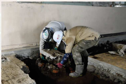
保存のため機械基礎を取り上げている様子 (傷をつけないよう人力で持ち上げています)
