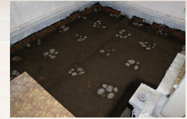
D. 東石基礎（集石遺構）
