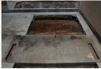
A. 石炭ボイラーの地下煙道
