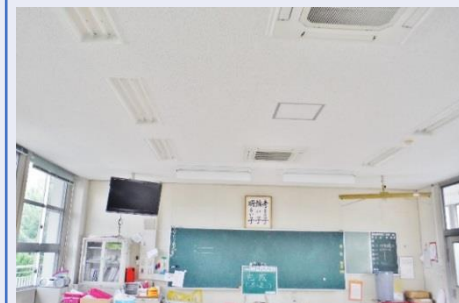
復旧後の教室の天井
