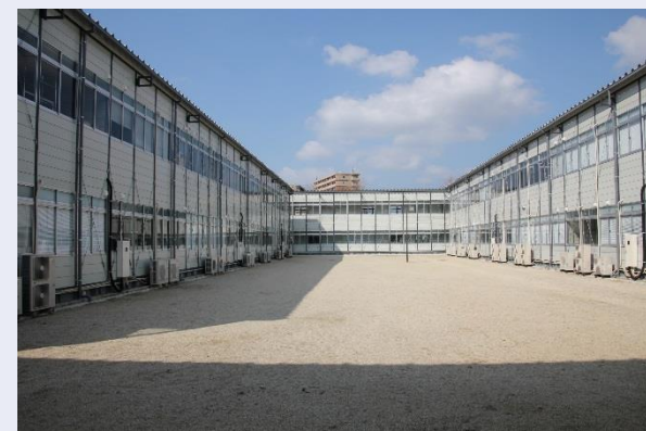
工学部1号館改築のため設置された仮校舎
