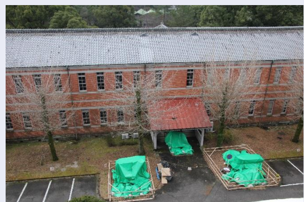
五高記念館の応急復旧（煙突の撤去）
