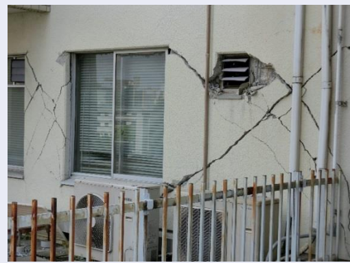
外来臨床研究棟の壁
