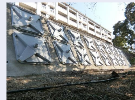
復旧後の擁壁
