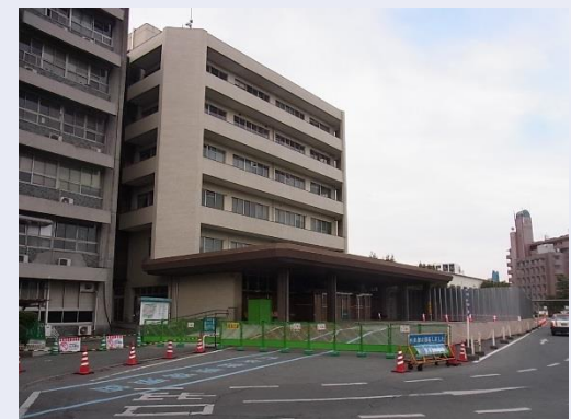
管理棟を取り壊し後に、取り壊しを開始する外来臨床研究棟、立入禁止措置中
