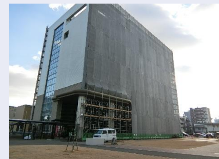
復旧作業の足場で囲われた建物
